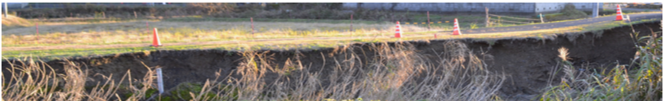
台風による志楽川の被害（吉坂地区 川にかかる橋は通行止め）
