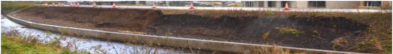
台風による志楽川の被害（田中地区）
